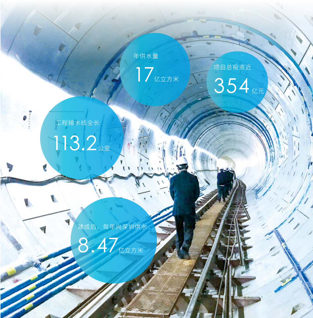
珠三角供水管道施工
